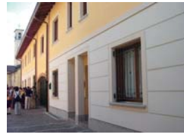
facciata esterna di Casa Gola
