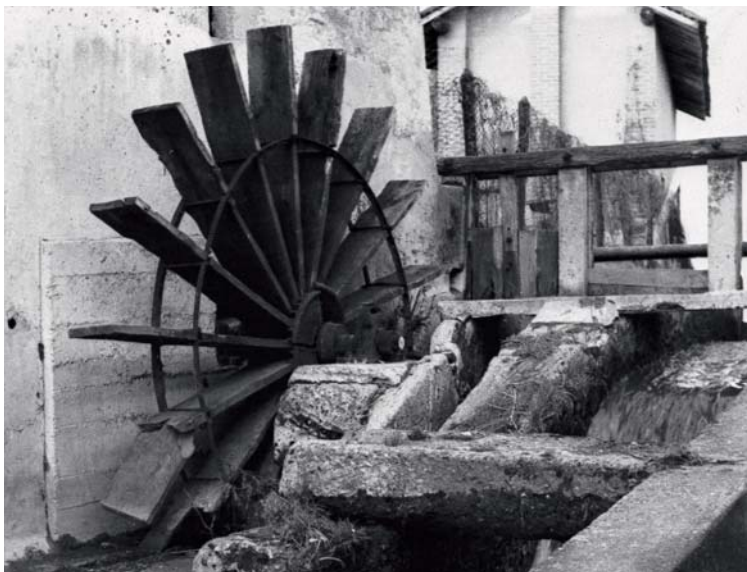
Il Mulino di Sotto, con la sua ruota in legno, prima che la roggia Calchera fosse interrotta
