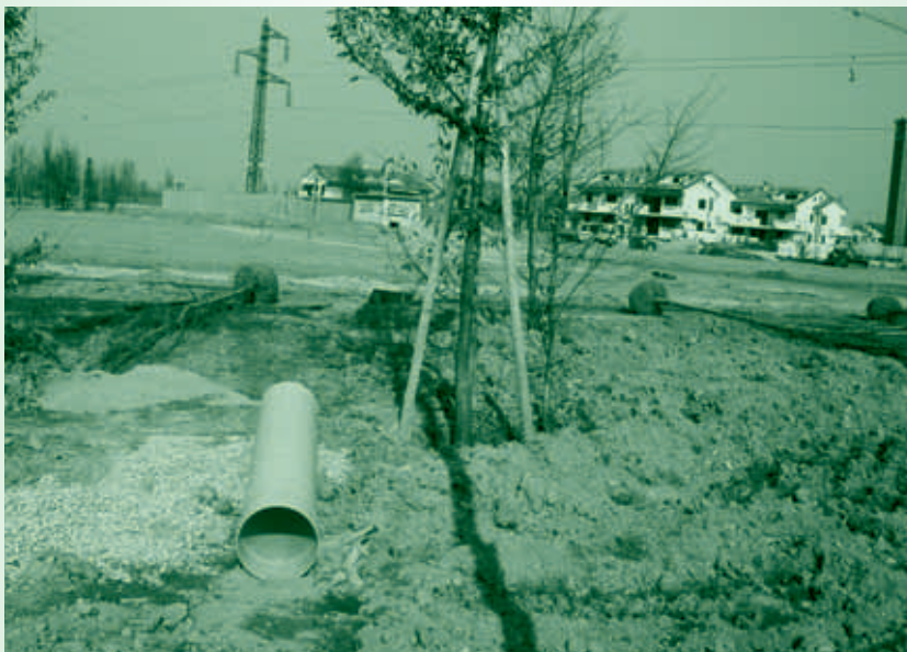
Bettolino: lavori in corso per la costruzione del parco
