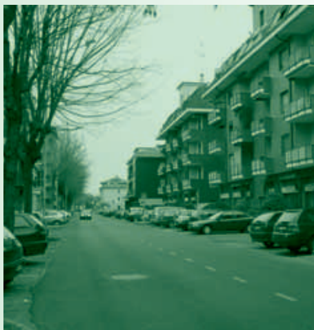
Lavori di riqualificazione di Viale Risorgimento.
